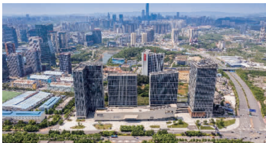
图为阳光城·启航中心项目
