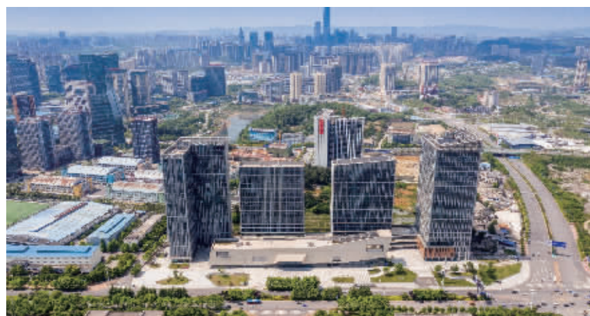
图为阳光城·启航中心项目
