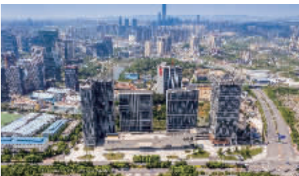
图为阳光城·启航中心项目
