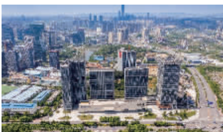
图为阳光城·启航中心项目
