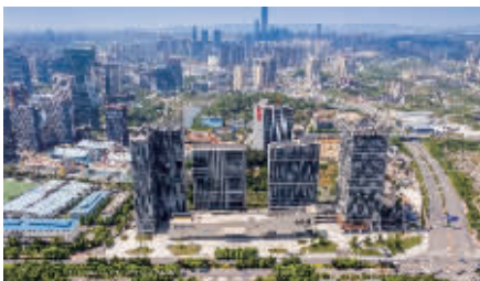
图为阳光城·启航中心项目
