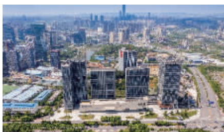
图为阳光城·启航中心项目
