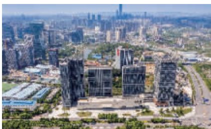
图为阳光城·启航中心项目
