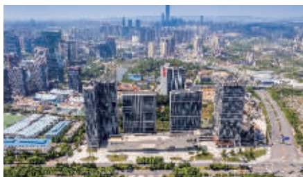
图为阳光城·启航中心项目
