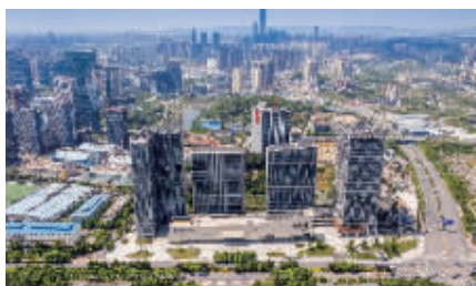
图为:阳光城·启航中心项目
