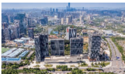
图为阳光城·启航中心项目
