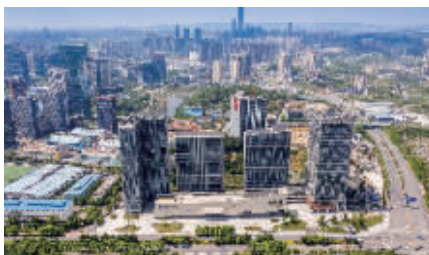
图为阳光城·启航中心项目
