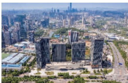
图为阳光城·启航中心项目
