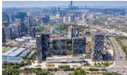
图为阳光城·启航中心项目
