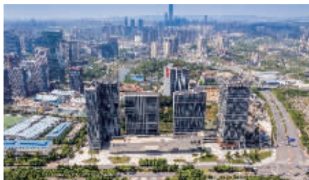
图为阳光城·启航中心项目
