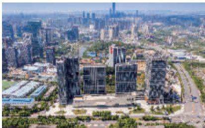
图为阳光城·启航中心项目
