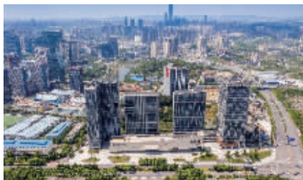
图为阳光城·启航中心项目
