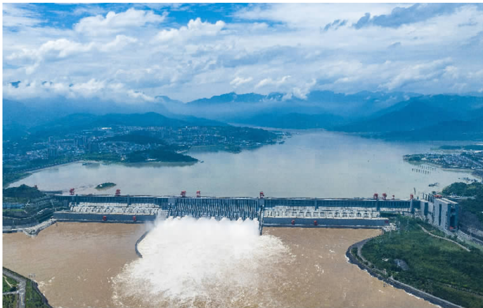
7月15日,三峡水库开启9个泄洪孔泄洪。日前,长江委发出调度令,调度三峡水库增开泄洪孔至9孔泄洪,加紧腾库。 新华社发
