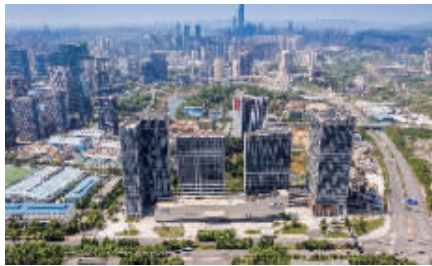
图为阳光城·启航中心项目
