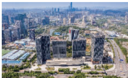
图为阳光城·启航中心项目
