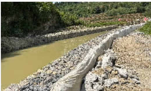
现场约60米长的河堤高度与相邻农田齐平
