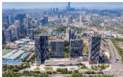
图为：阳光城·启航中心项目
