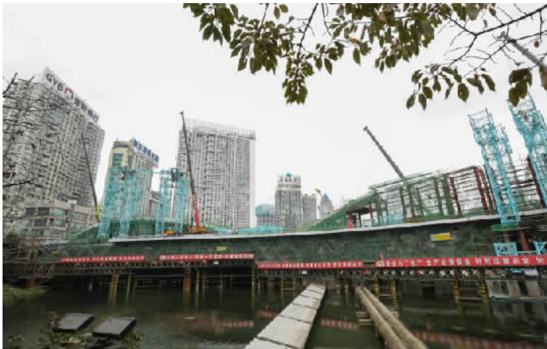
筑城广场大桥见雏形
