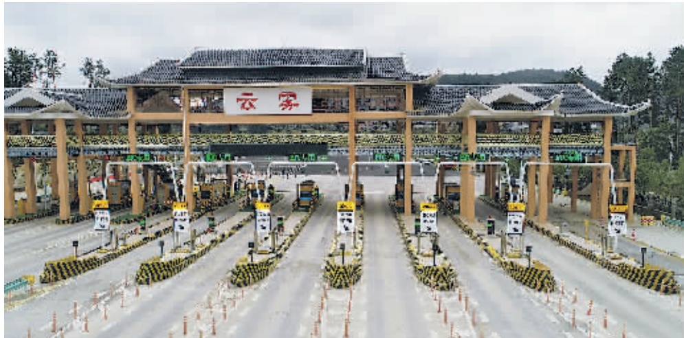
云雾收费站各车道上,均安装了黄色箱体式的“智能节点”集成设备 周永 摄
