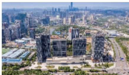
图为阳光城·启航中心项目
