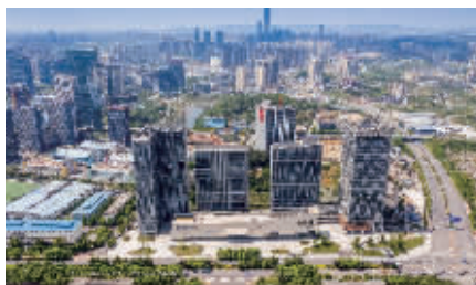
图为阳光城·启航中心项目
