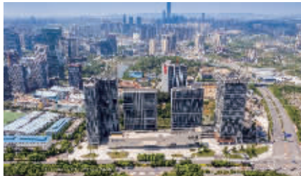
图为阳光城·启航中心项目
