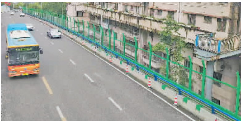
北京西路邻近海马冲隧道路段的旧隔声屏障拆除后,云岩区市政工程管理所已安装部分新的隔声屏障固定框架。
