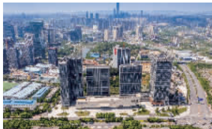
图为阳光城·启航中心项目
