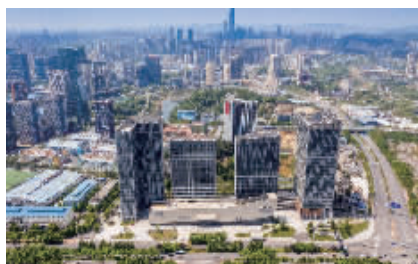
图为阳光城·启航中心项目
