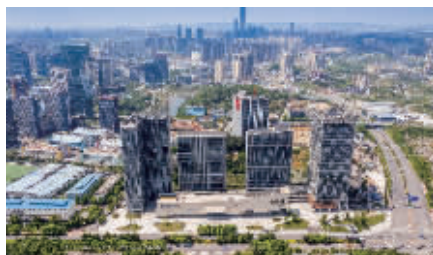
图为阳光城·启航中心项目
