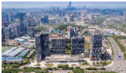
图为阳光城·启航中心项目
