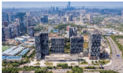
图为阳光城·启航中心项目
