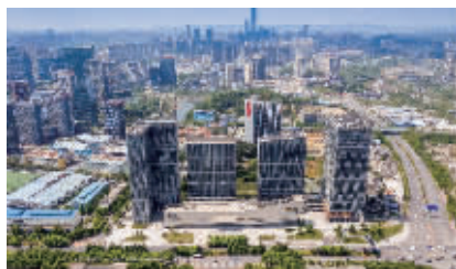
图为阳光城·启航中心项目
