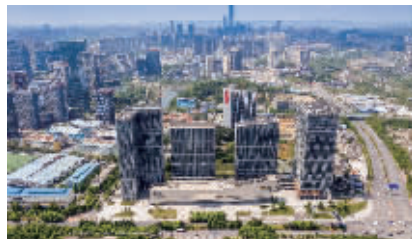
图为阳光城·启航中心项目
