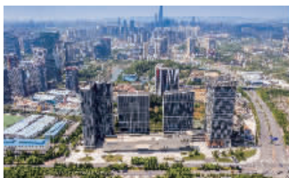
图为阳光城·启航中心项目
