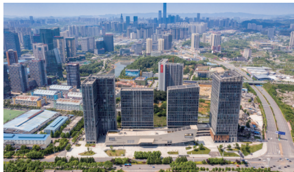
图为阳光城·启航中心项目
