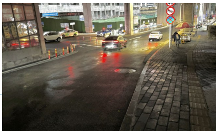
匝道改造后,车行道约6米宽,可供两车并排通行。
