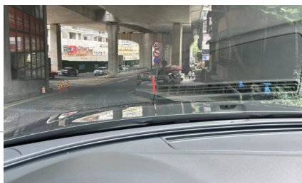
匝道改造前,人行道凸出,车行道仅供单车通。
