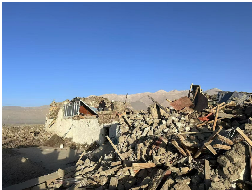
这是1月7日在日喀则市定日县长所乡通来村拍摄的房屋倒塌情况。 新华社发
