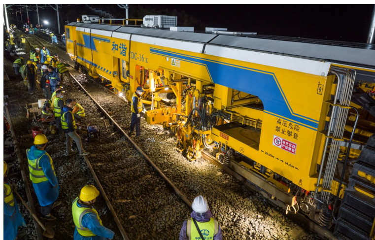
拨接作业现场
