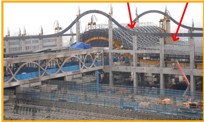
提升的钢结构屋盖(箭头所指)
