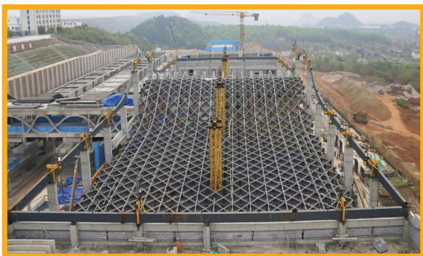
俯瞰钢结构屋盖
