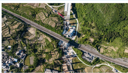
建设中的贵平高速底至特大桥
