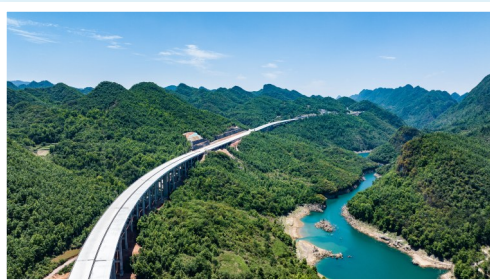
建设中的贵平高速掌布至谷洞路段
