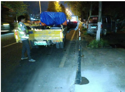
工作人员在给人行道安装隔离桩
