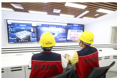
工作人员在调试内部设备
