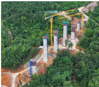
据新华社电 7月9日,随着最后一方混凝土注入模板,由中铁八局承建的黄百铁路贵州段六志河特大桥25号墩身浇筑完成,桥梁下部结构进入施工新阶段,为后续工程推进奠定了坚实基础。
