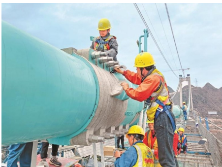
工人在桥上作业
