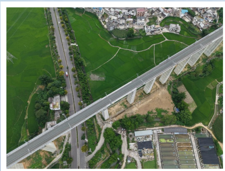
盘兴高铁清水河特大桥
