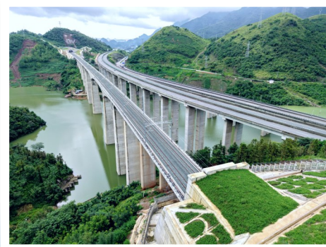
盘兴高铁纳怀河大桥
