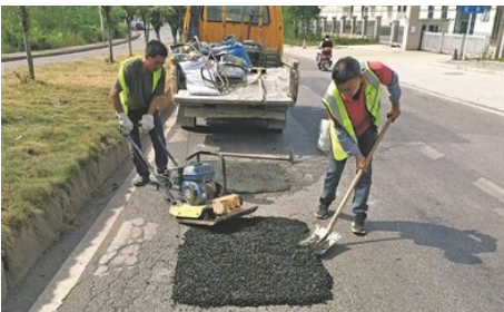
工人对破损路面进行修复
