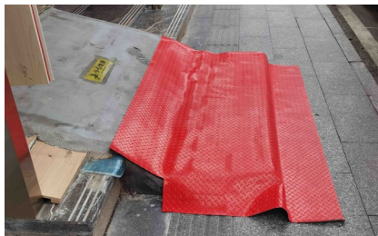
拆除前,水泥台阶还被红色胶垫遮挡着
