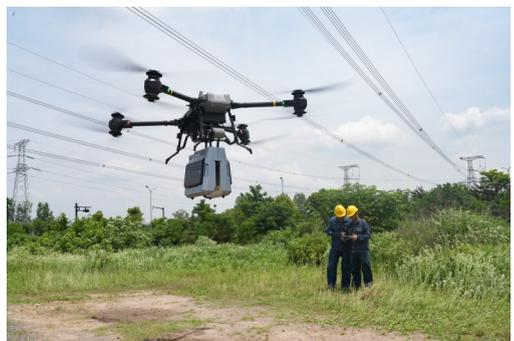
2025年5月22日，在位于浙江省诸暨市的500千伏线路现场，工作人员操作搭载了地线断股带电修补机器人的大疆无人机起飞，对线路进行修复。
