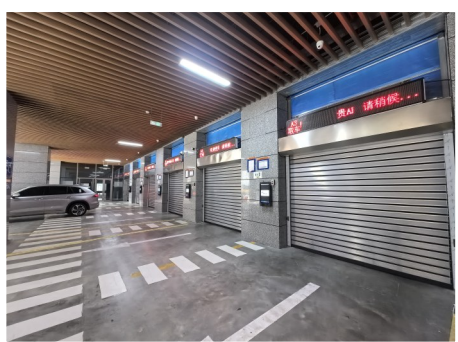
沙河街智慧停车场内部
